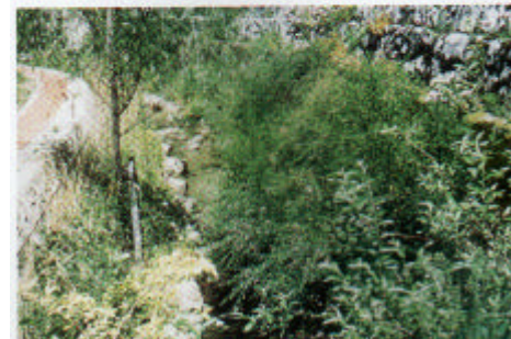
施工後：ホタルの飛翔とともに植物も成長し、水路の生物を観察したり地域の人が散歩を楽しむ事のできる環境になっています。
