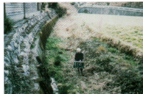
施工前：雨水排水及び家庭排水の排水路として利用されていた横断。平養料には流れが早く、泥だらけの水が溜まり、蚊のすみかとなっていました。
