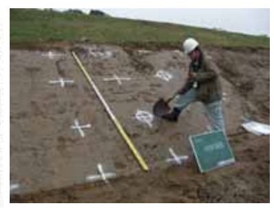
【堤防法面硬度試験状況】
