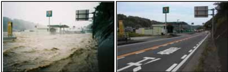
写真-冠水時の国道の状況
