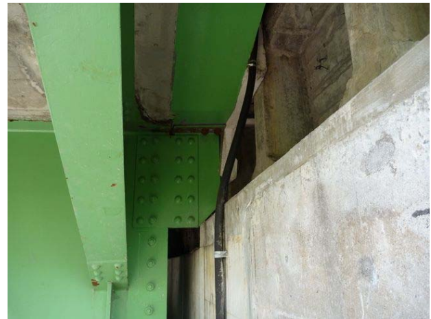
写真-2 補修後の状況
