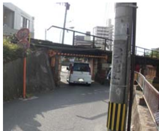
【鉄道橋桁下状況】
