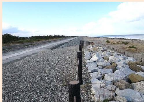
既設堤防の多くが流されず残っていたため、これを活用した設計としています。南端には、震災前に植えられていた松がかろうじて生き延びていたため、後世に残すような工夫をしています。
