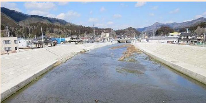
鹿折川河口から八幡橋上流 230mまで、3タイプの護岸を配置しています。
