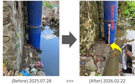
写真-3 Ancar におけるセンサー（設置前後）
