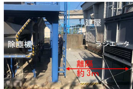
写真-2 除塵機と建屋間
