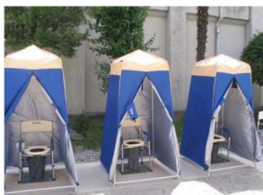
写真-1 マンホールトイレ
