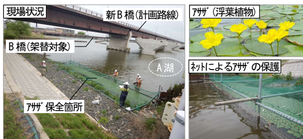
図-1 B橋架替事業におけるアサザの保全状況
