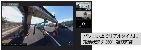
図-4 360° カメラを活用した安全パトロール
