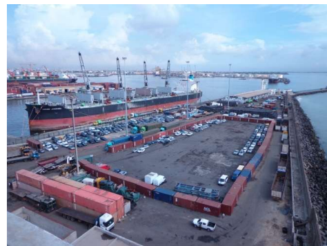
写真-1 改修前の第三埠頭全景（ダカール港）
