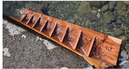
写真-2 河川に設置した簡易魚道
