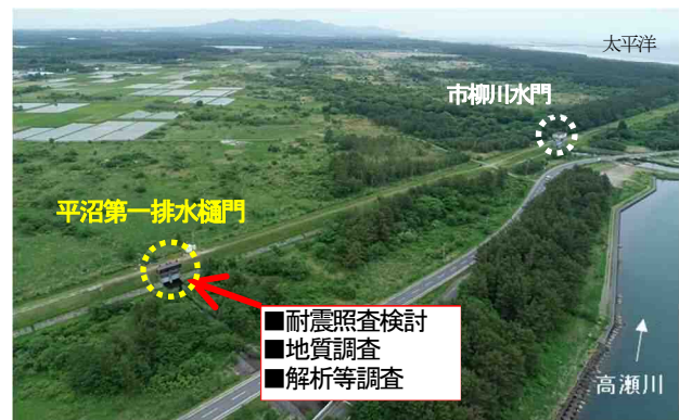
図-3 平沼第一排水樋門（UAV写真）
