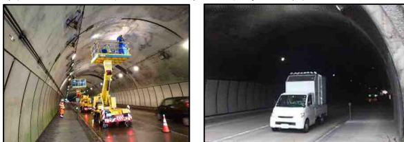
写真-1 点検状況(左:トンネル点検車, 右:画像計測技術)
