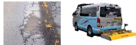
写真-3 (左)舗装の状態、(右)電磁波レーダー調査車両
