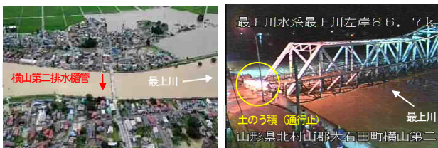
図-1 令和2年7月豪雨における被災状況 (左：全景、右：横山第二排水樋管 CCTV)
