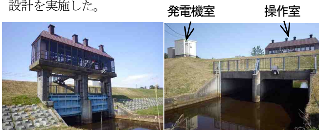
図-2 平沼第一排水樋門写真（左：川表、右：川裏）
