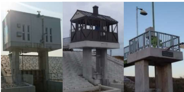
写真-1 樋門上屋構造の例 (左: RC, 中: AL, 右: 上屋無し)
