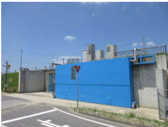
図-2 海岸陸閘の一例
