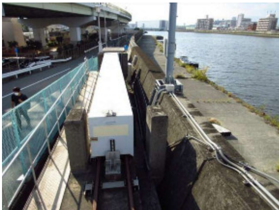
図-1 河川陸閘の一例
