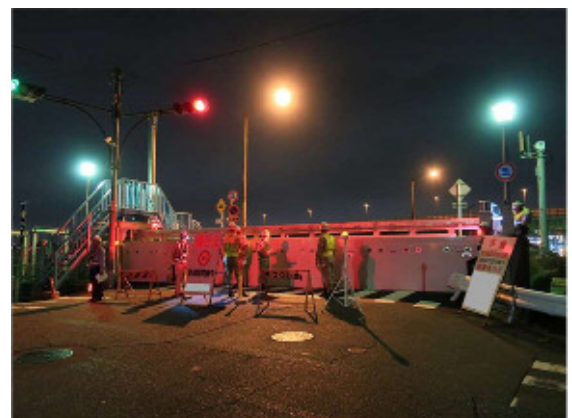
図-4 電動陸閘閉鎖の様子(夜間閉鎖訓練)
