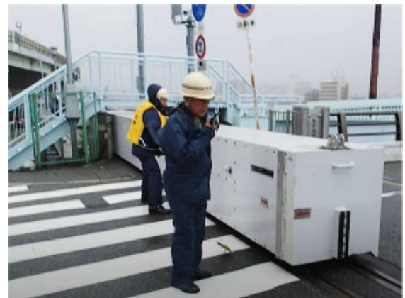
図-3 手動陸閘閉鎖の様子(2018年台風21号) (出典：治水事務所公開動画)
