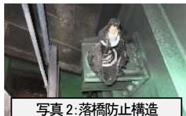
写真 2: 落橋防止構造
