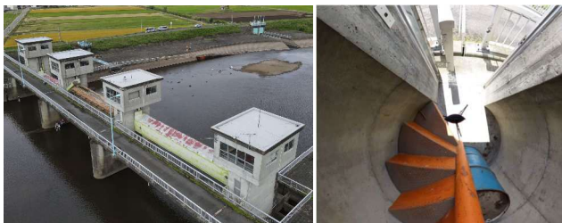
写真-1 君島堰状況（左：全景，右：中空断面状況）
