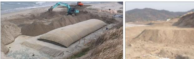
図-2 SP施工状況（左：埋戻し前、右：埋戻し後）
